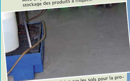
Mise en place de bacs de rétention pour le stockage des produits à risques.
