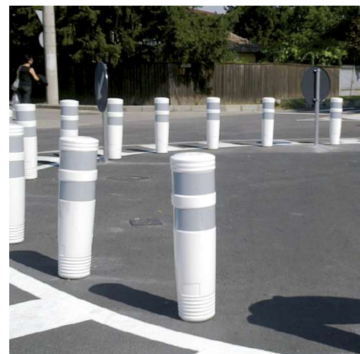
Balise K5d, placée sur une zone de travaux temporaire
